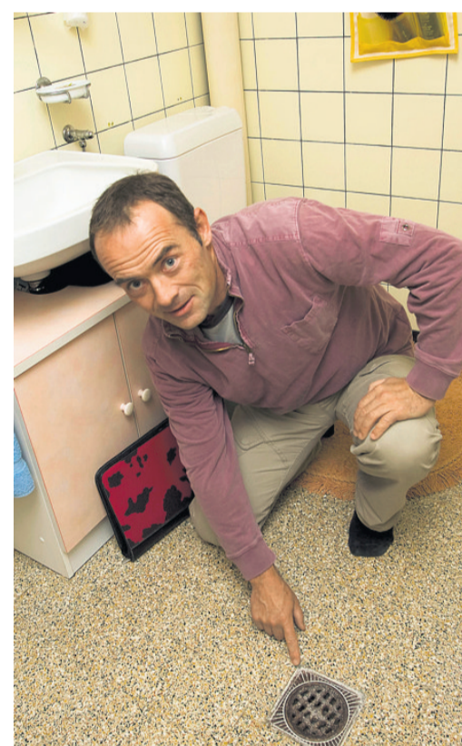
Le radon peut s'infiltrer à l'intérieur de la maison par les canalisations, la tuyauterie, les aérations ou les fissures dans le plancher.
